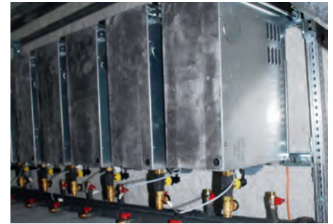
→ Les dimensions de la micro-pompe à chaleur eau/eau 30 WWH correspondent à une unité centrale d'ordinateur de bureau.
