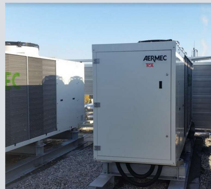
Installations PAC – Rte de St. Julien
