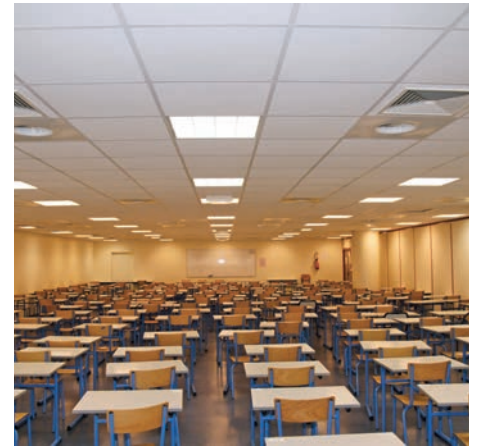
→ Dans les salles de classe, les climatiseurs « tout air neuf » (en fait des minis CTA) se mettent en service uniquement lorsqu'il y a détection de présence grâce à des capteurs infrarouges intégrés dans le faux plafond. Ils s'arrêtent lorsque les étudiants quittent la salle, moyennant une temporisation.
